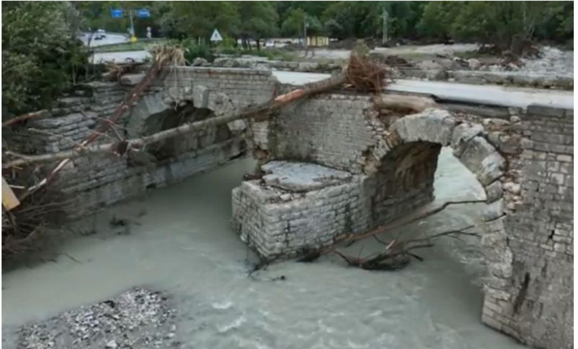
Ponte Romano a Cantiano sulla vecchia Flaminia
